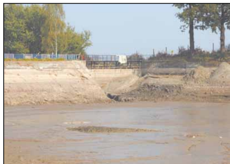
Remont zapory i wałów na tamie
